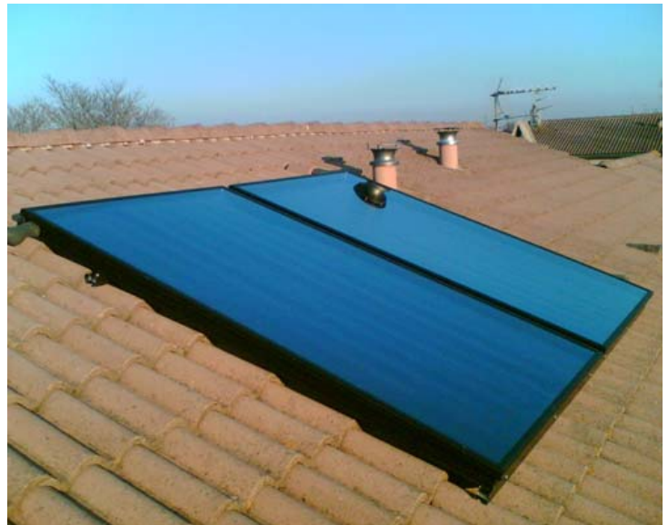
Solar hot water panels. ©Entreprise Crestey www.toulouse-solaire.com
